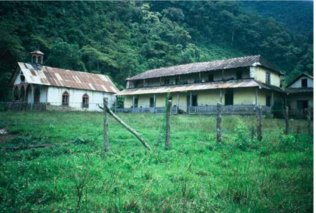
Als die Peru-Aktion das Gelände 1987 erwarb, war das Gebäude schon viele Jahre unbewohnt
